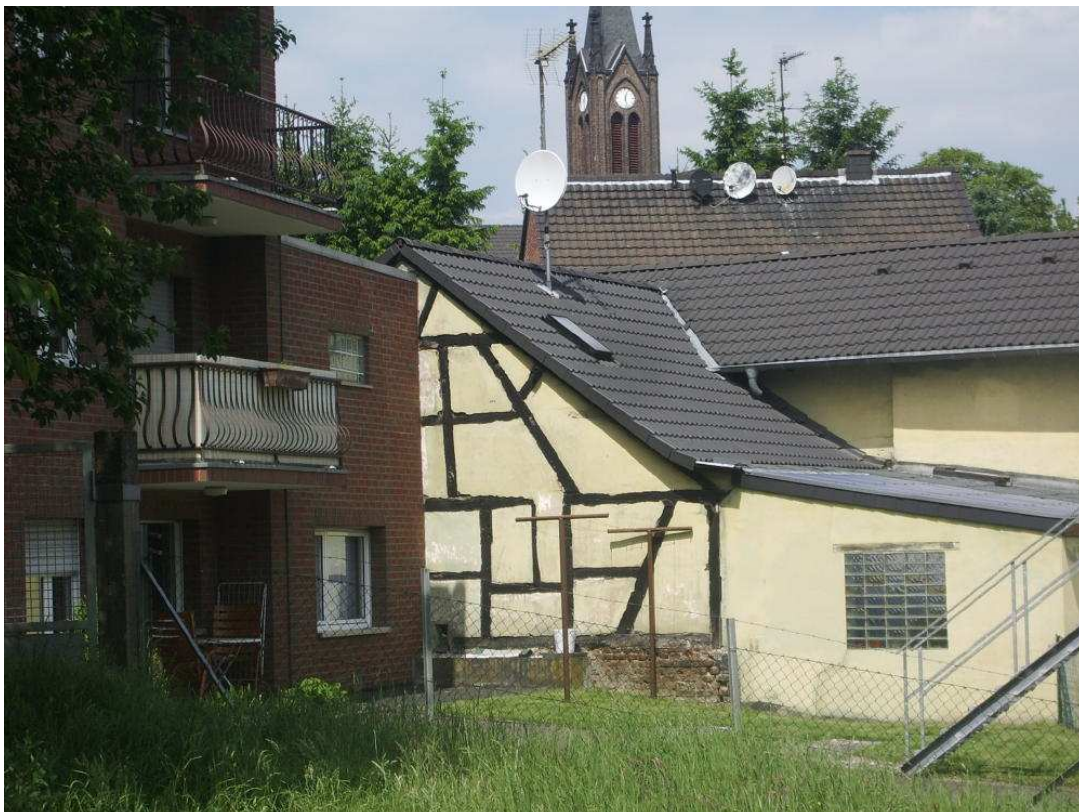
Rückfront der ehem. Braunsfelder Mühle, Bergheim-Glessen, Foto: 21.5.2008 (R. Kreiner)
