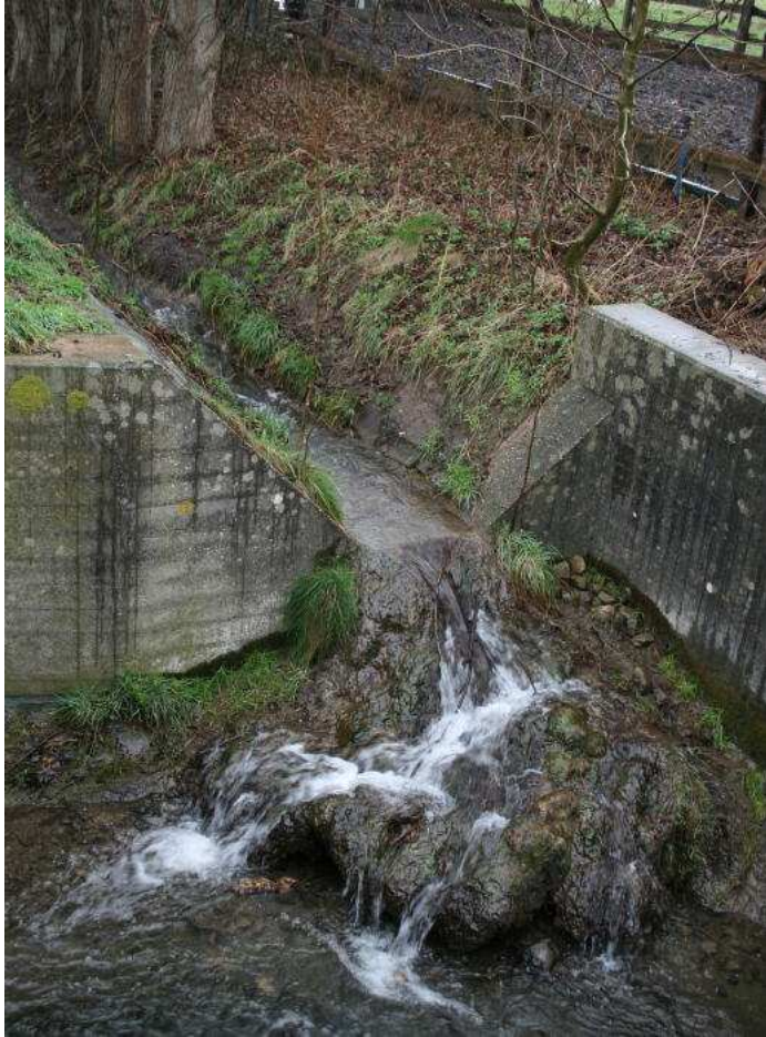
Sinterablagerung am Absturz der Einmündung des Keuschenbroicher Bachs in den Pulheimer Bach oberhalb der Sintherner Ölmühle (Naturdenkmal). Die Ablagerung verweist auf den hohen Mineralgehalt des Bachwassers. Foto: Dr. R. Kreiner, 29.12.2009
