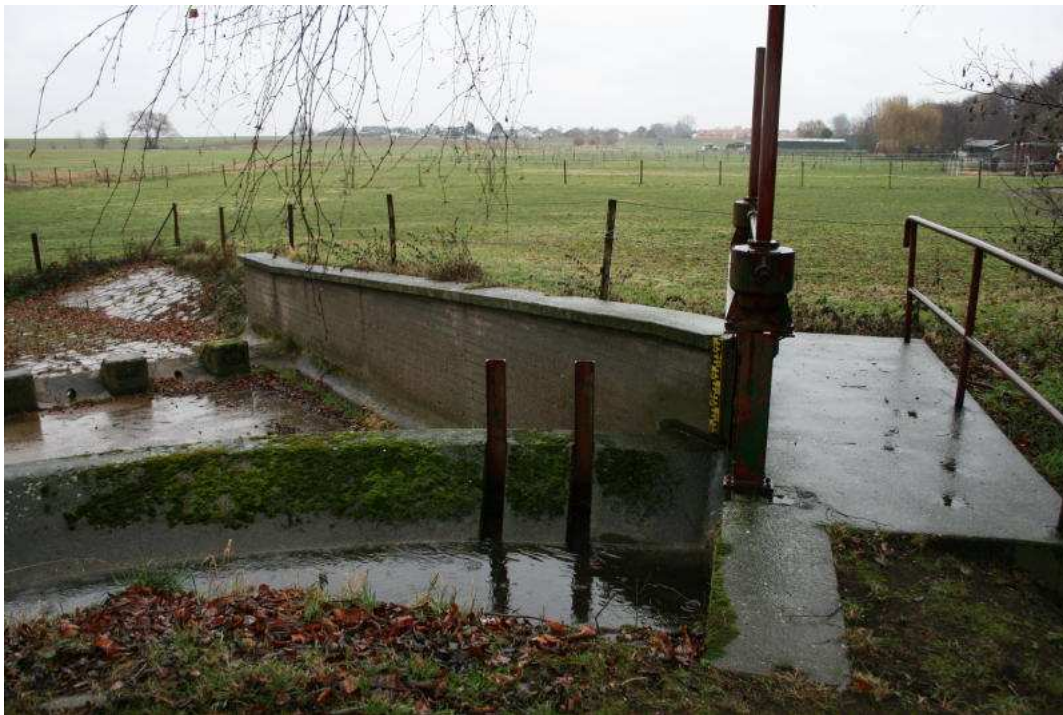
Hochwasserentlastungsanlage mit Schütz und Überlauf im Pulheimer Bach an der Sinthener Ölmühle. Die Wiesen dienen im Hochwasserfall als Retentionsraum. Im Hintergrund der Hochwasserschutzdamm und die Ortslage Sinthern. Fotos: Dr. R. Kreiner, 29.12.2009
